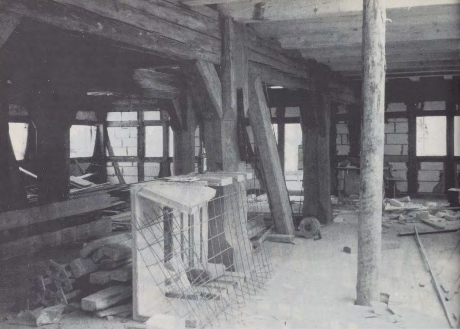
Blick ins zweite Obergeschoß während des Umbaus des Horber Talhauses.
