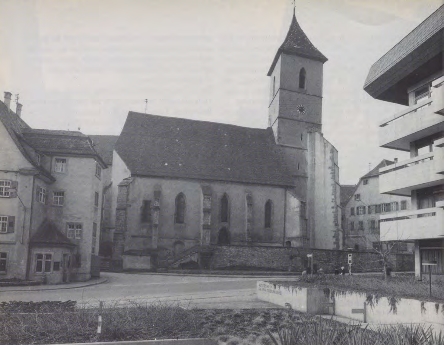
Die Liebfrauenkirche in Horb. Links das Gasthaus zum Hirsch mit einem Treppenhauseinbau aus den 20er Jahren, rechts der Neubau des Altersheims Ita von Toggenburg, errichtet Mitte der 60er Jahre an der Stelle des alten Spitalhofs. Das stattliche Haus zwischen Kirche und Altersheim hat der Erweiterung des Krankenhauses weichen müssen. (Foto von 1971)
