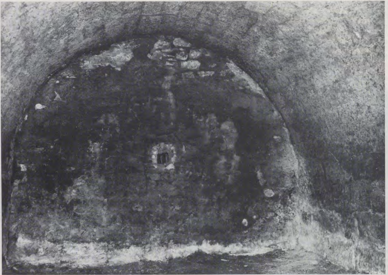
Rußfang-Gewölbe mit Öffnung zum angrenzenden Rußbrennraum; die ursprüngliche größere Öffnung ist noch andeutungsweise erkennbar.
