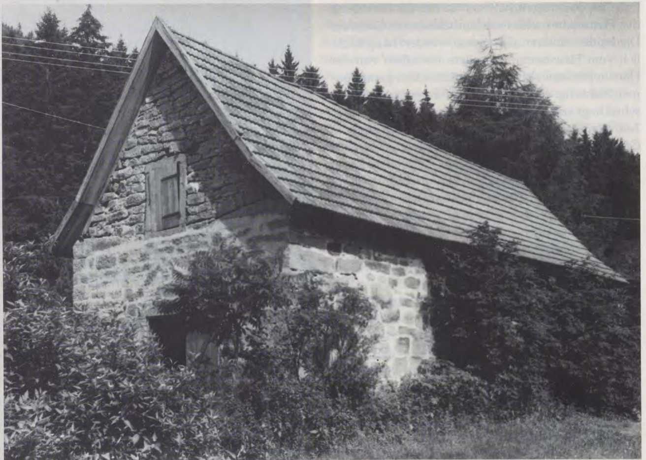
Gesamtansicht der Rußhütte in Enzklösterle. In der Giebelfront unten der Zugang zum Rußfanggewölbe, oben zur Filtervorrichtung.
