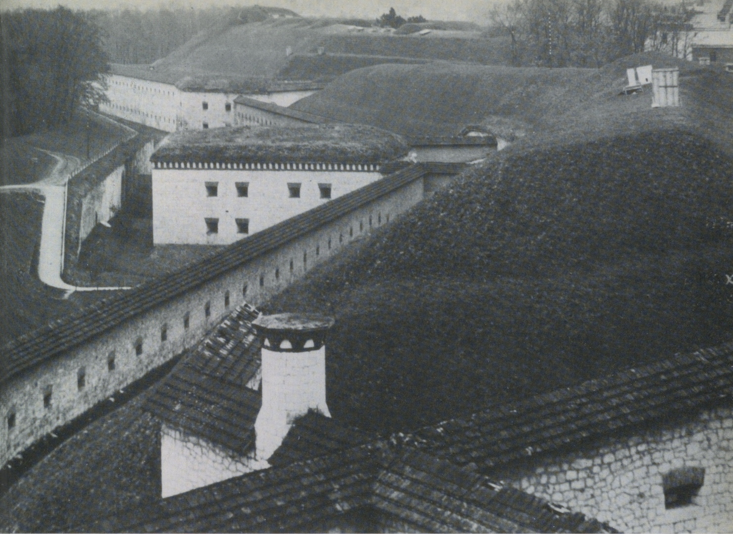
Verlauf des Festungsringes am Osthang des Michelsbergs mit (von innen nach außen): Wall, Mauer, Graben und Glacis, hier bereits bewaldet. 1904
