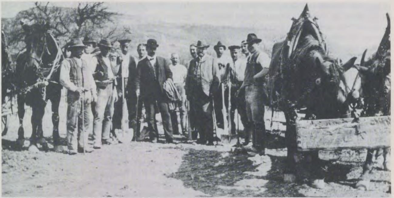
Grundsteinlegung der Hallen 1905. In der Mitte links Theodor Fischer (mit Mantel am Arm), rechts Louis Laiblin (im hellen Anzug).
