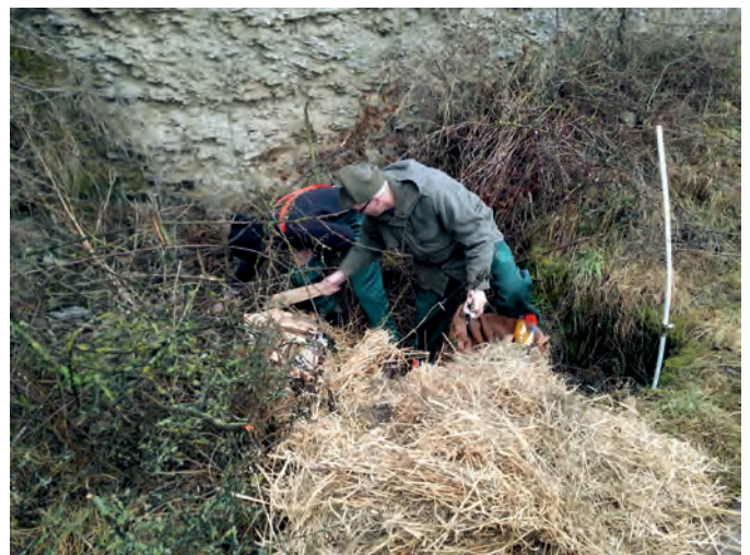
Die Felsnische mit dem Bildstock der »Heiligen Familie« war hinter Dornengebüsch fast verschwunden und der Bildstock durch Tropfwasser stark geschädigt.
