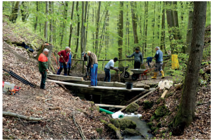
Schonung der geschützten Umgebung im Schönbuch und auch eine erhebliche Kostenreduzierung haben die Akteure mit ihrer solidarischen Brückenrestaurierung »von Hand« erreicht.
