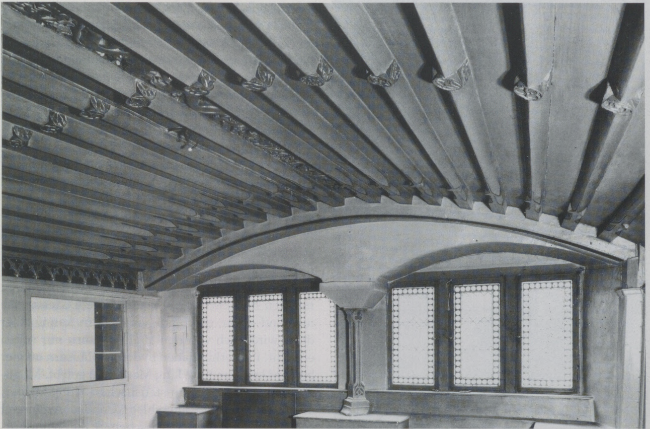
Aufwendige Bohlenbalkendecke in einem Patrizierhaus der Ravensburger Oberstadt, zeitgleich mit der Decke S. 46
