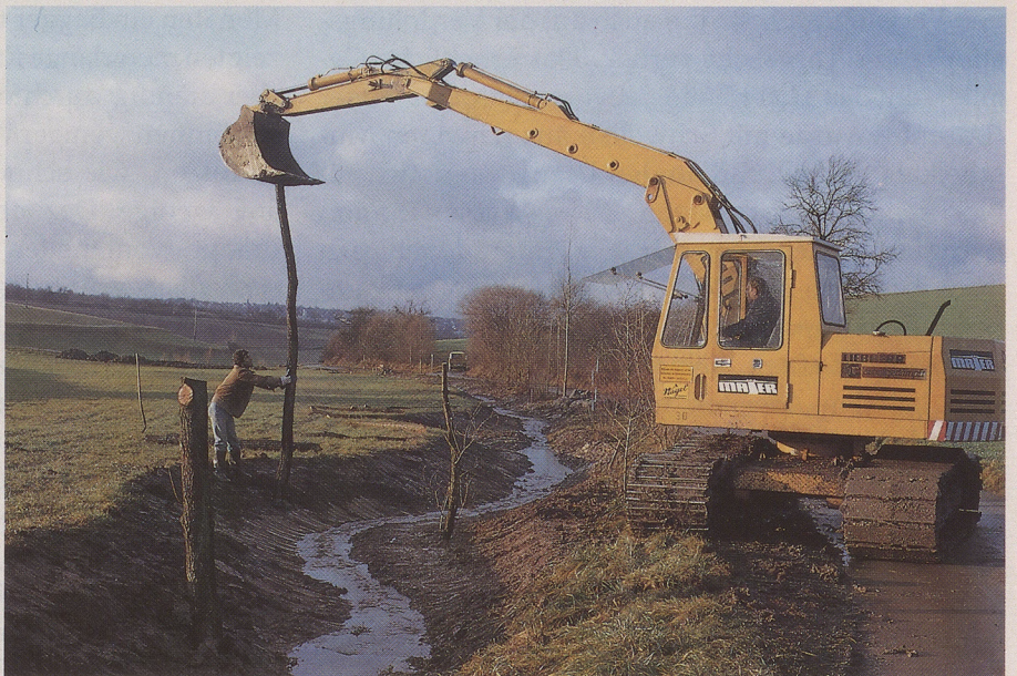
Das «Pflanzen» von Kopfweiden mit dem Bagger: unterschiedlich starke Kopfweidenäste werden etwa eineinhalb Meter in den Boden gedrückt und schlagen im Frühjahr dann aus.
