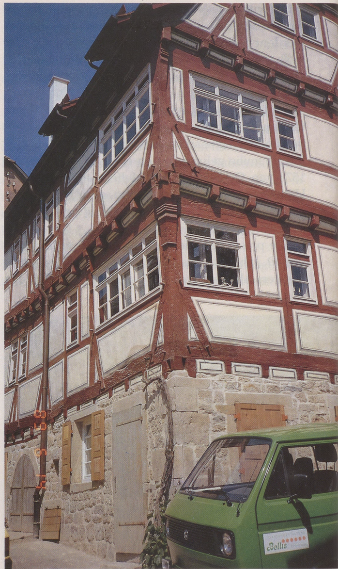
Fassadenausschnitt der früheren Lateinschule, Kirchplatz 7, in Markgröningen.
