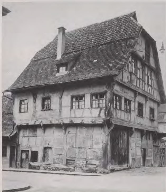
Das Vogthaus, Ravensburg, Charlottenstraße 36, vor der Restaurierung.
