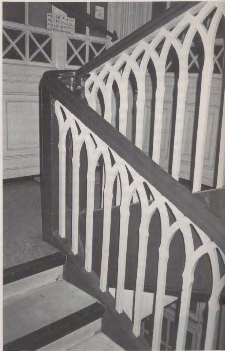
Das Treppengeländer im Gebäude Charlottenstraße 1 stammt möglicherweise noch aus der Bauzeit 1811, da es Anklänge an Thouret'sche Entwürfe zeigt. Im Dachgeschoß sind sogar die originalen Treppenstufen erhalten.
