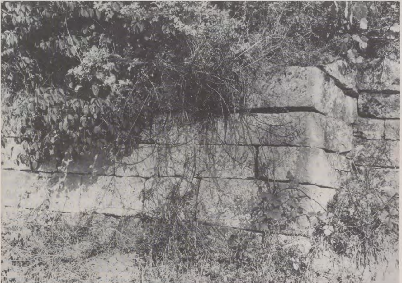
Kunstvoll aufgesetzte Trockenmauer am Weinbergweg des Hofbergs. Die unterste Steinlage liegt etwa einen halben Meter über dem Wegniveau, Zeichen dafür, daß der Weg laufend abgeschwemmt und tiefer gelegt wurde.
