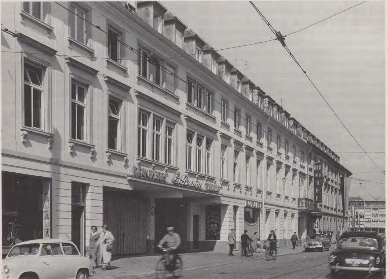
Im Jahre 1828 übersiedelte der Hofbuchdrucker und Hofbuchhändler Gottlieb Braun in die Schloßstraße, die heutige Karl-Friedrich-Straße. Zerstört im Zweiten Weltkrieg, wurde das Gebäude nach 1945 in den von Friedrich Weinbrenner vorgegebenen Maßen wieder aufgebaut.
