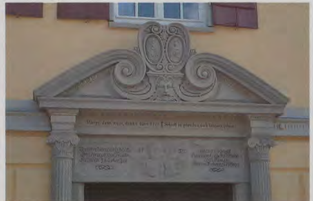
Hofansicht des Gutshauses Georgenau, Türsturz mit Wappen und Bauinschrift aus dem Jahre 1739.
