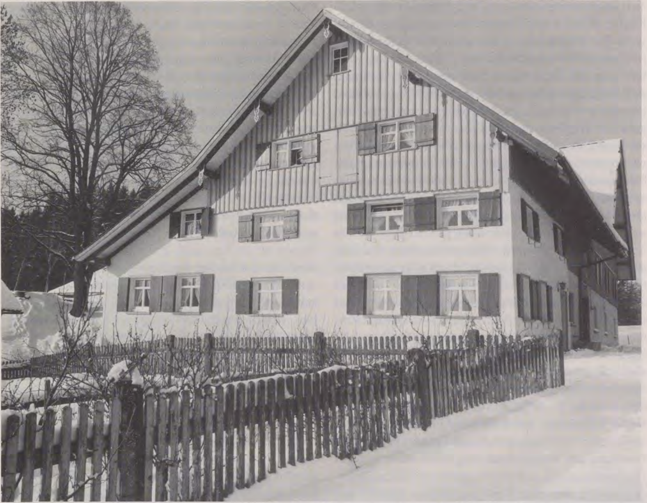
Ein landwirtschaftliches Gebäude im Westallgäu. Hinter der holzverschalteten Fassade unter dem Dach die beiden Gesinderäume. Von innen wollte die heutige Bäuerin die Dienstbotenkammern jedoch nicht fotografieren lassen.
