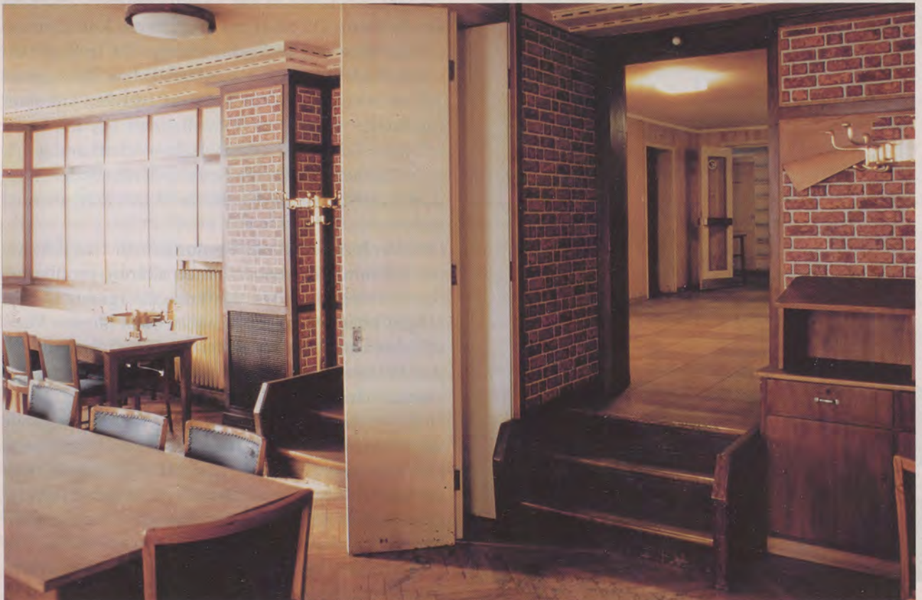
Doppeleingang zum Turnersaal mit Klappwand dazwischen. Um dem im früheren Scheuerteil eingebauten Saal mehr Raumhöhe zu geben, wurde er um einige Stufen abgesenkt.
