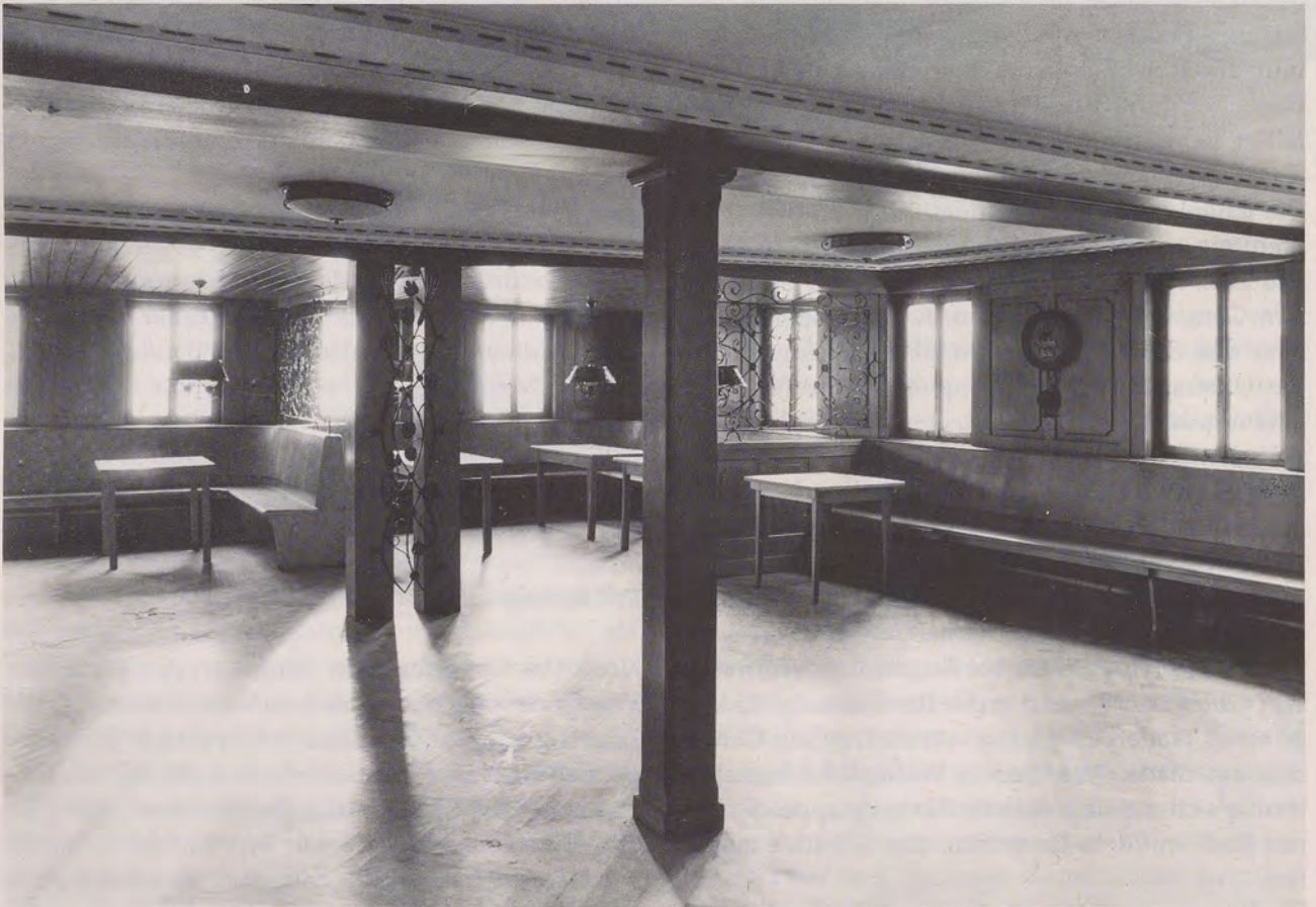
Die vertäfelte Gaststube des «Goldenen Rads». An der Decke erkennt man die gestuften Gipsprofile, über die die Belüftung und Entlüftung der Gasträume erfolgte.
