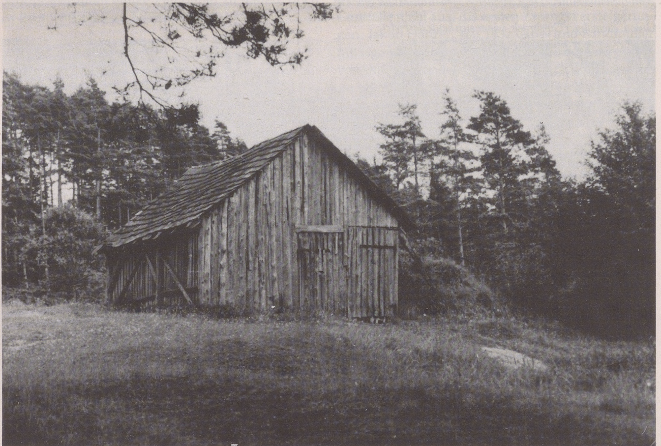
Eine der Hütten mit einer Sandmühle bei den Sandgruben, um 1960 abgebrannt. Mit dem Mahlstein aus Buntsandstein wurden die Steinbrocken im Mahlgang per Pferdeantrieb zerkleinert und pulverfein gemahlen.
