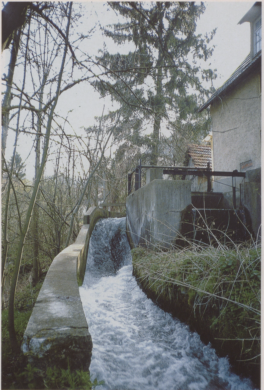
In dieser Mühle in Brucken wurde die Wasserkraft seit Jahrzehnten nicht mehr genutzt. Mögliche Jahresenergie 76 000 kWh
