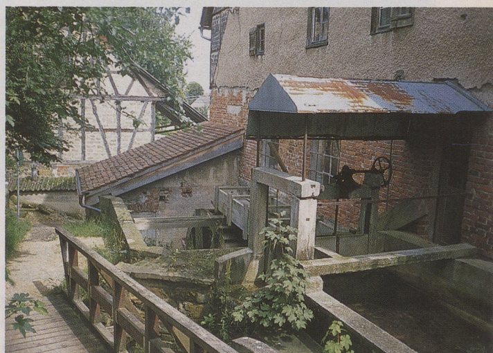
Die Stadt Weilheim hat entschieden, dieses obereschlächtige Wasserrad an der Oberen Mühle zu erhalten.
