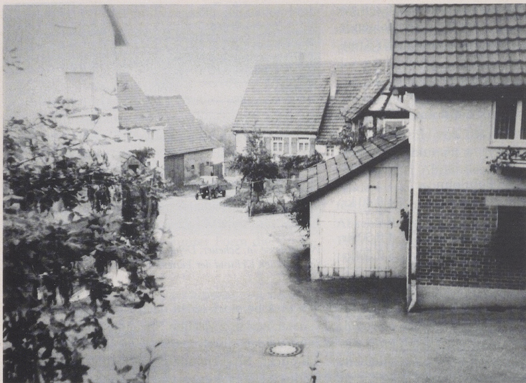
Der Grüne Weg in Aichschieß früher: Das quergestellte Bauernhaus, Grüner Weg 6, schloß das Straßenbild nach unten ab; rechts schaut ein Teil des ehemaligen Armenhauses hervor. Beide wurden 1983 abgebrochen.
