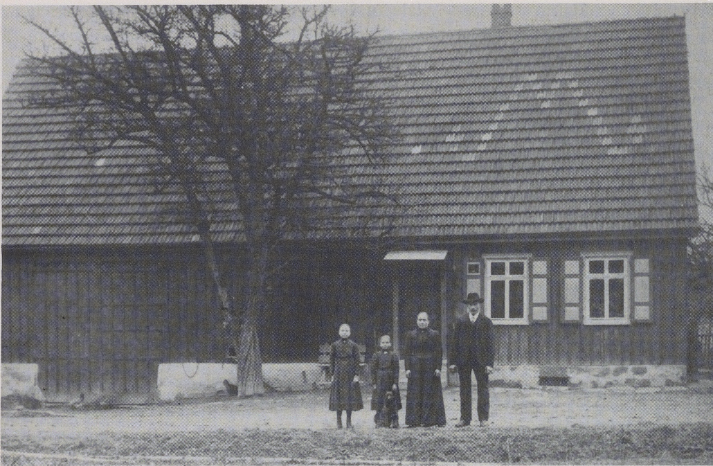
Remstalstraße, ehemals Haus Mös- singer, Aufnahme von ca. 1910. Im Dach mit andersfarbigen Ziegeln ein schwung- volles M.
