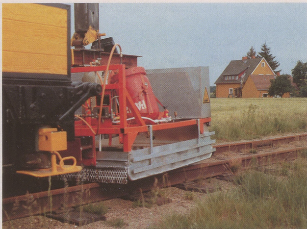
Infrarotgerät der Deutschen Bundesbahn im Einsatz zur Aufwuchsbekämpfung.
