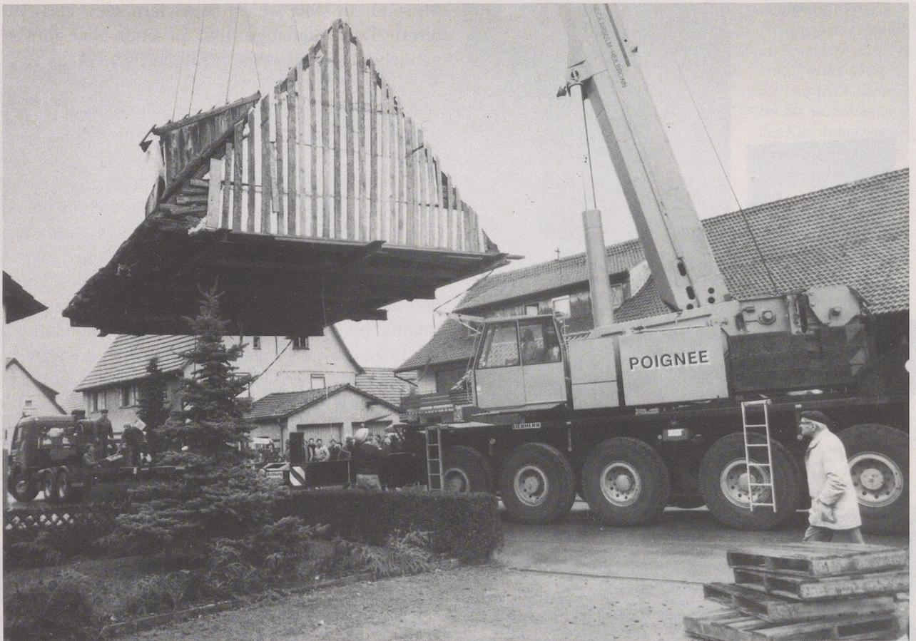
In Hößlinsülz ist das Dach des Armenhauses mit einem Kran komplett abgehoben, wird geschwenkt und auf einen Tieflader gesetzt. Möglichst viel originale Substanz konnte so erhalten werden.
