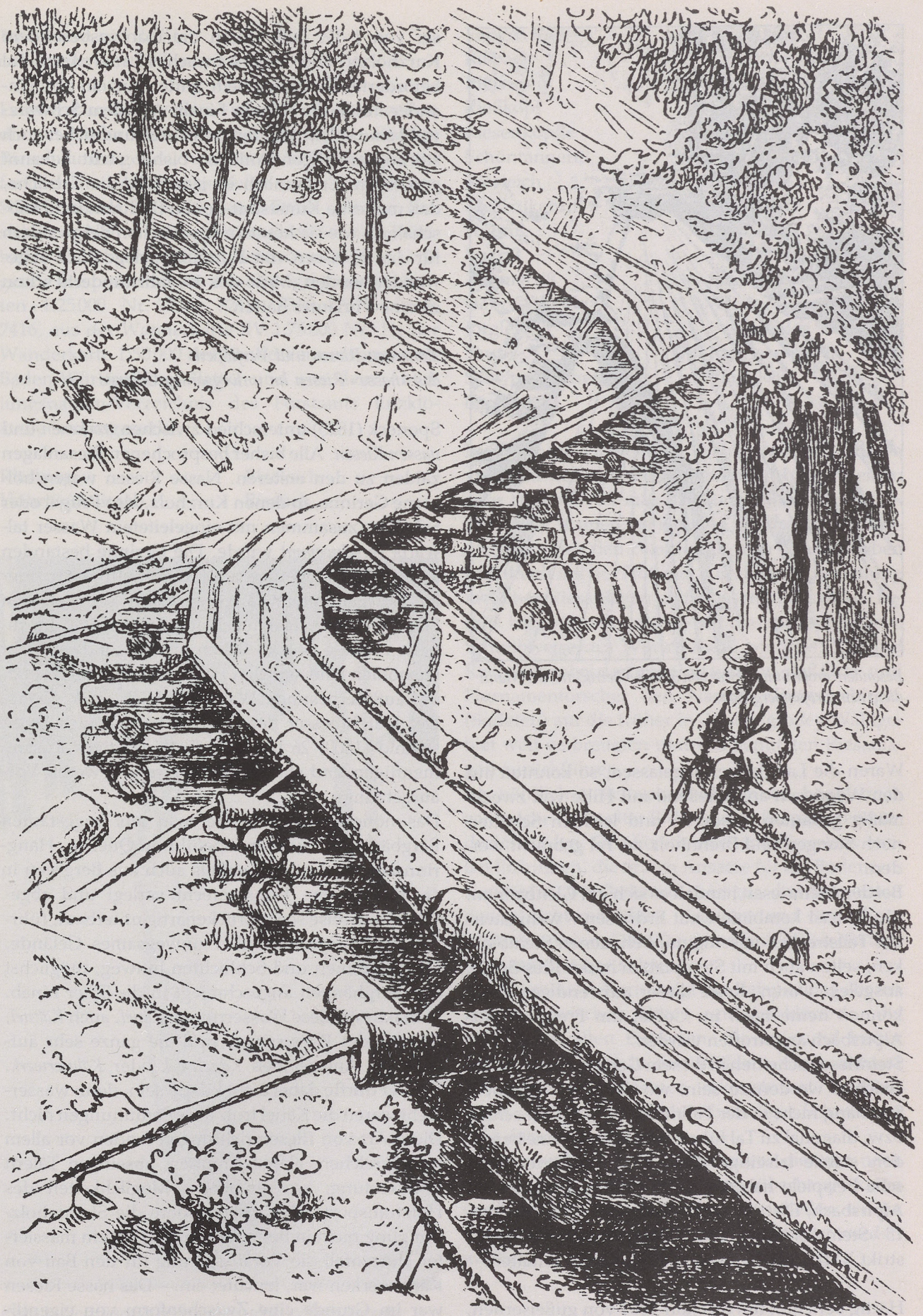
Stammholzriese geringerer Muldentiefe mit Unterlagen und Abstützungen; im Hintergrund teilt sich die Riese nach oben.
