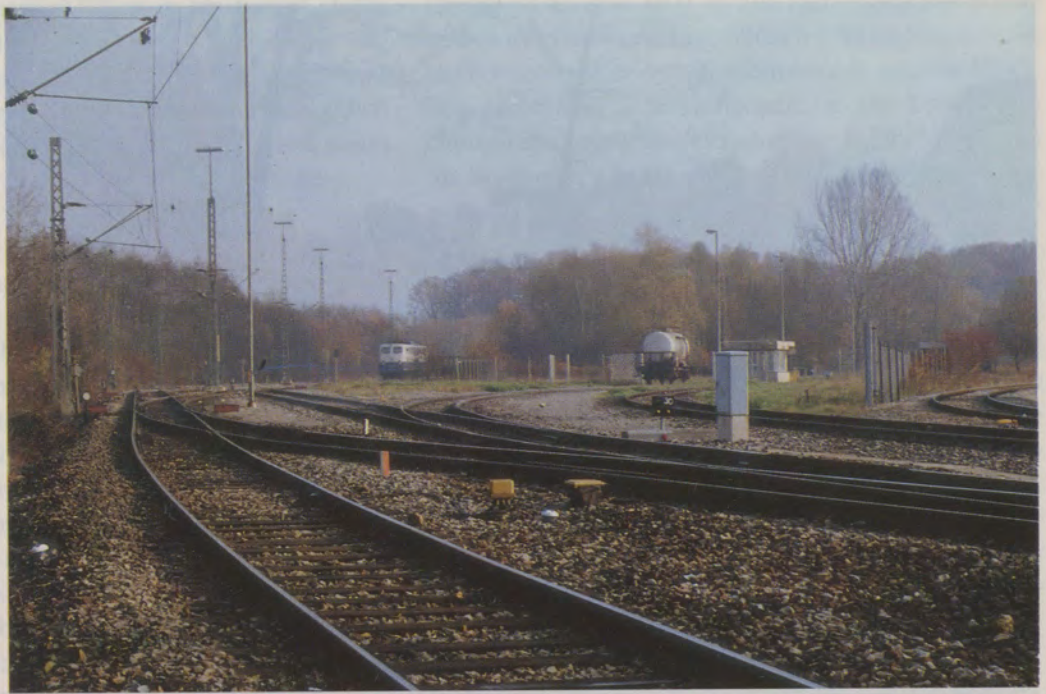
Die elektrifizierten Gleisanlagen der Zuckerfabrik Offenau bei Heilbronn, – bald ohne Rübentransporte?
