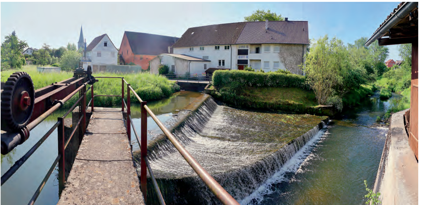
Blick auf das Stauwehr der Haubersbronner Wieslaufmühle bei Schorndorf. Die «BürgerInnen-Energie-Genosschaft Remstal eG» möchte das Wehr so umgestalten, dass es Fische überwinden können. Gleichzeitig soll das Wassertriebwerk verbessert werden.
