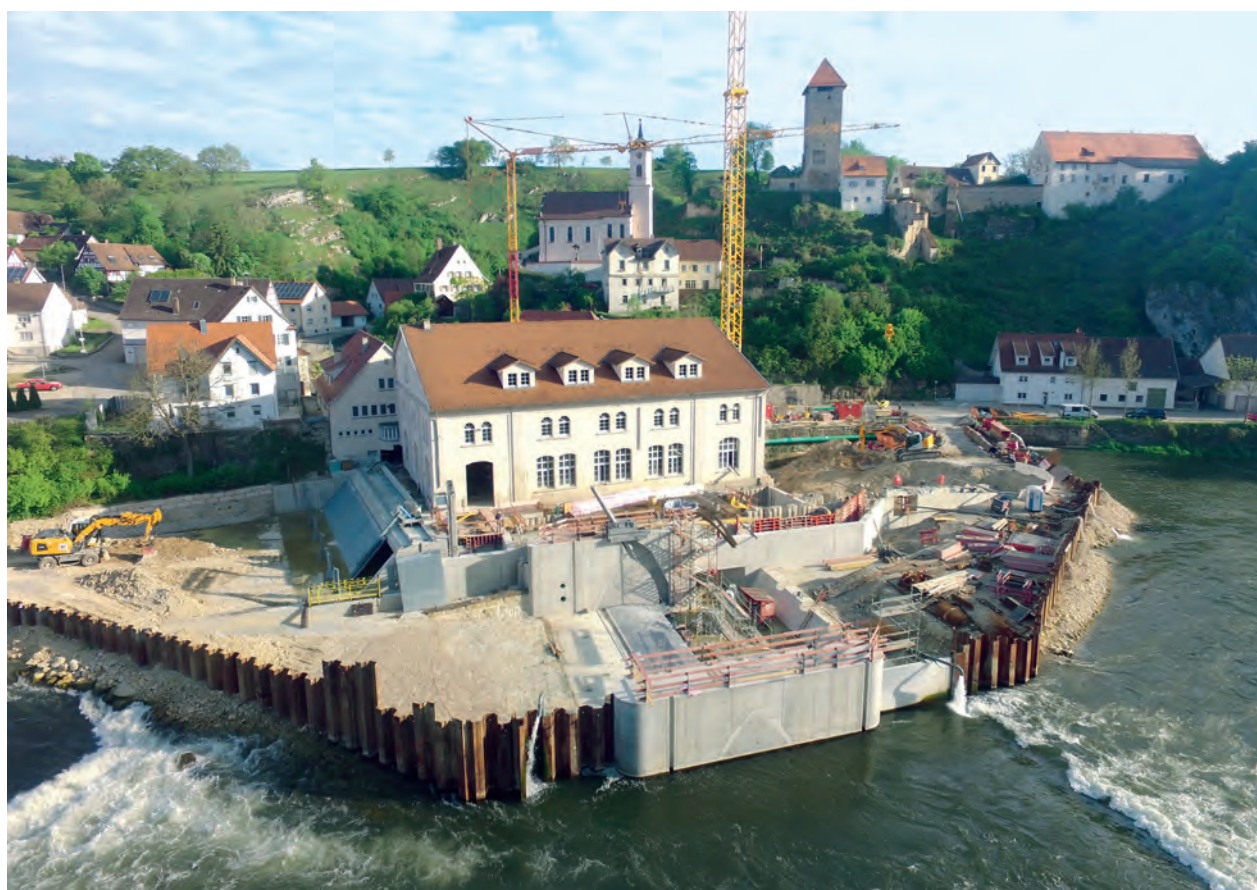
Ein neues Stauwehr des Donau-Wasserkraftwerks Rechtenstein soll Fischen besser den Weg weisen, den Hochwasserschutz bestärken und eine weitere Turbine ermöglichen. Antrag auf Genehmigung zum Bau: 1985, die amtlichen Stempel erfolgten schließlich 2015. Bis Herbst 2017 soll das Wehr fertig sein.
