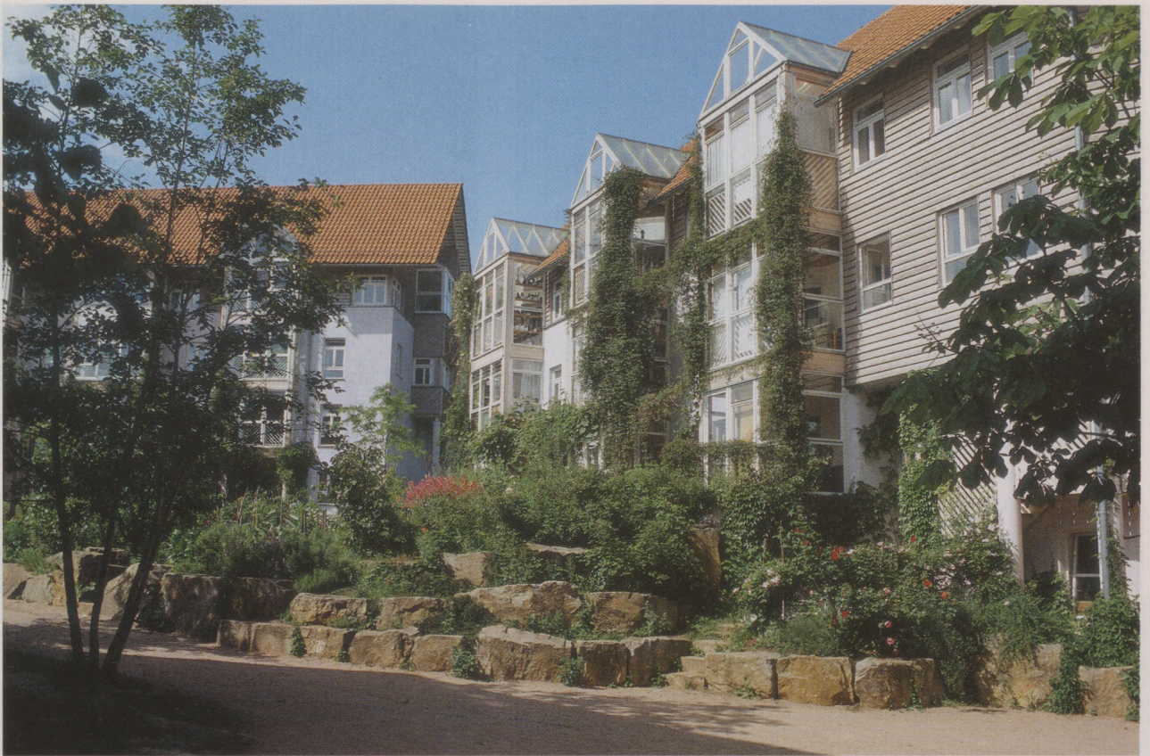
Blick in einen der drei Innenhöfe der Tübinger Schafbrühl-Siedlung. In der Nähe der Gebäude befindet sich der private Gartenbereich, vor den Trockenmauern der von allen Bewohnern gemeinsam benutzte Raum.
