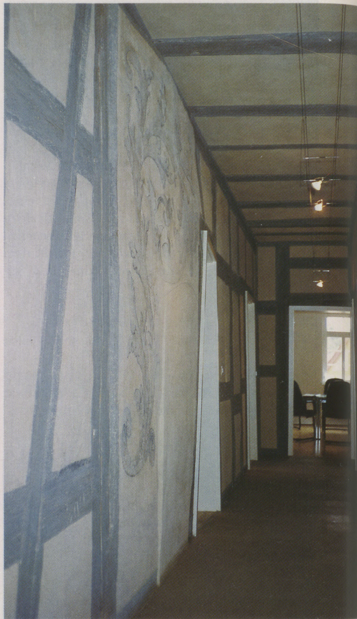
Beletage in der Marbacher «Kaserne»: die alte Raumeinteilung ist belassen und verträgt sich mit der Nutzung der Büroräume. An der Wand kam barocke Bemalung zutage.
