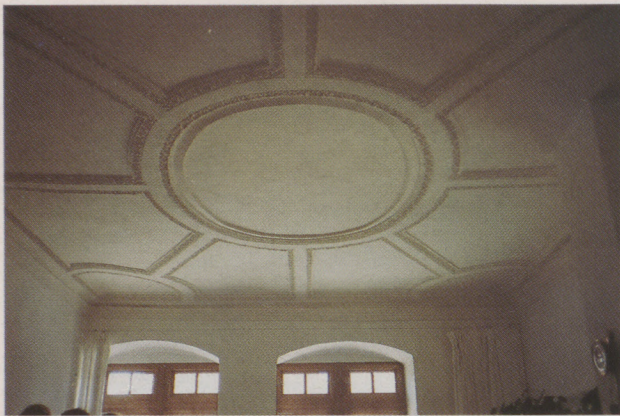
Vogtshaus Horb-Dettensee: In jedem Raum des Obergeschosses ist eine Stuckdecke mit anderen Mustern angebracht.
