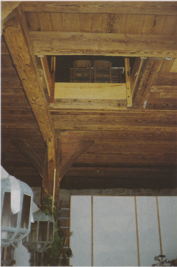
Luke zum Hochziehen und Herablassen von Salzsäcken im Erdgeschoß des ehemaligen Salzstadels; die frühere Funktion des Gebäudes bleibt auch im Innern ablesbar.
