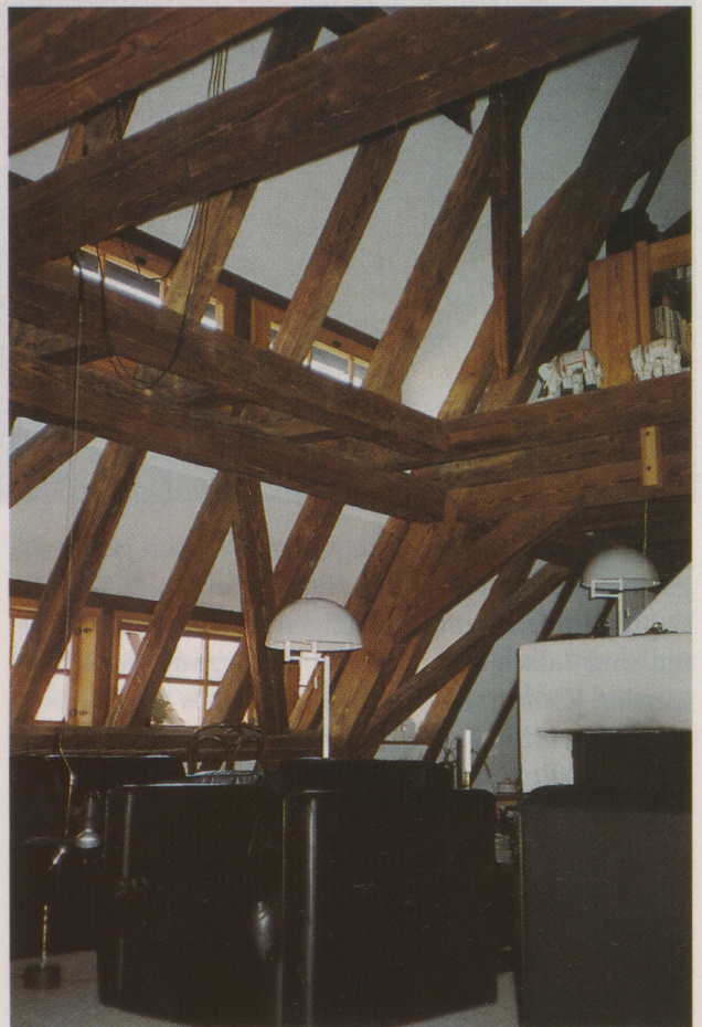
Speichergebäude in der Tübinger Unterstadt. Typisch für solche Bauten sind schmale Fensteröffnungen in den Wänden und kleine Dachgauben in den Dächern. Wohnraum im Dachstuhl mit sichtbarer Holzkonstruktion.
