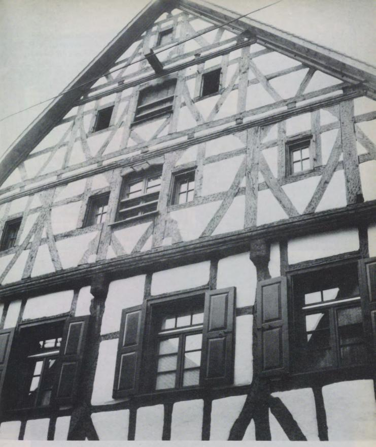
Schema: dreischiffige Längsteilung (bedingt durch die Hausbreite von ca. 12 m) und dreizonige Querteilung. . . . Während im Erdgeschoß dieses Schema klar ausgeführt werden konnte, mußte im Obergeschoß zur Ausbildung einer größeren, zur Straße orientierten Stube der Raster aufgegeben werden. Die räumliche Gliederung und die Erschließung
