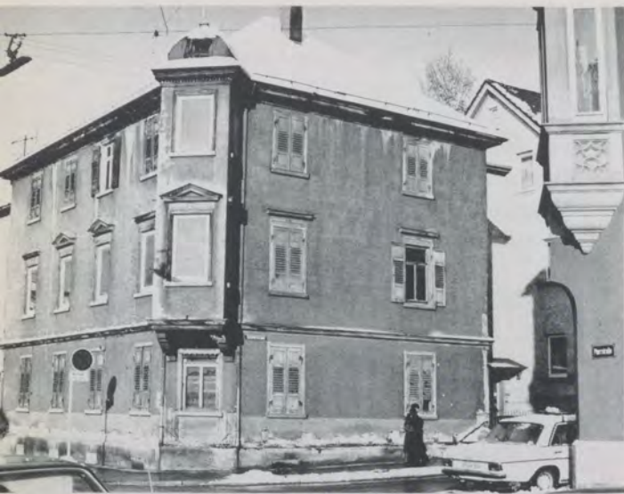
Abb. 3: Auch im total heruntergewirtschafteten Zustand sind die Qualitäten des Baus noch zu erkennen – ein Abbruchkandidat wie es viele in unseren Städten gibt.
