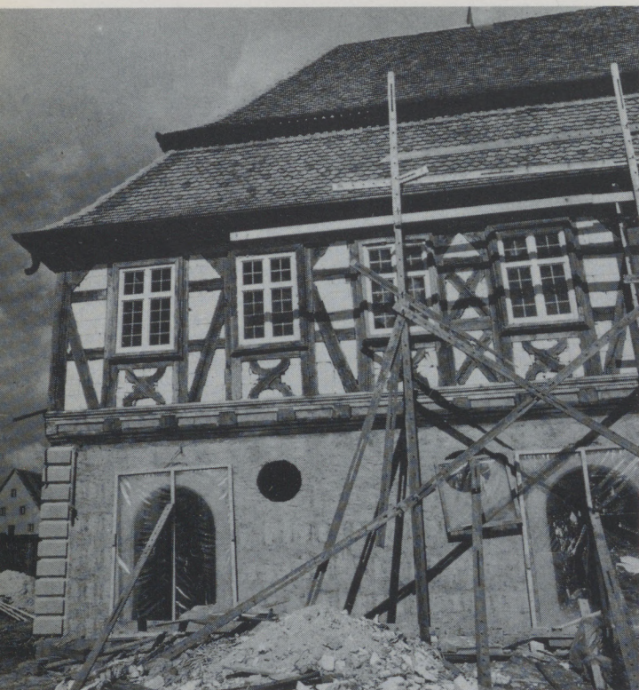
Das Gasthaus zur Krone aus Oberampfrach beim Wiederaufbau
