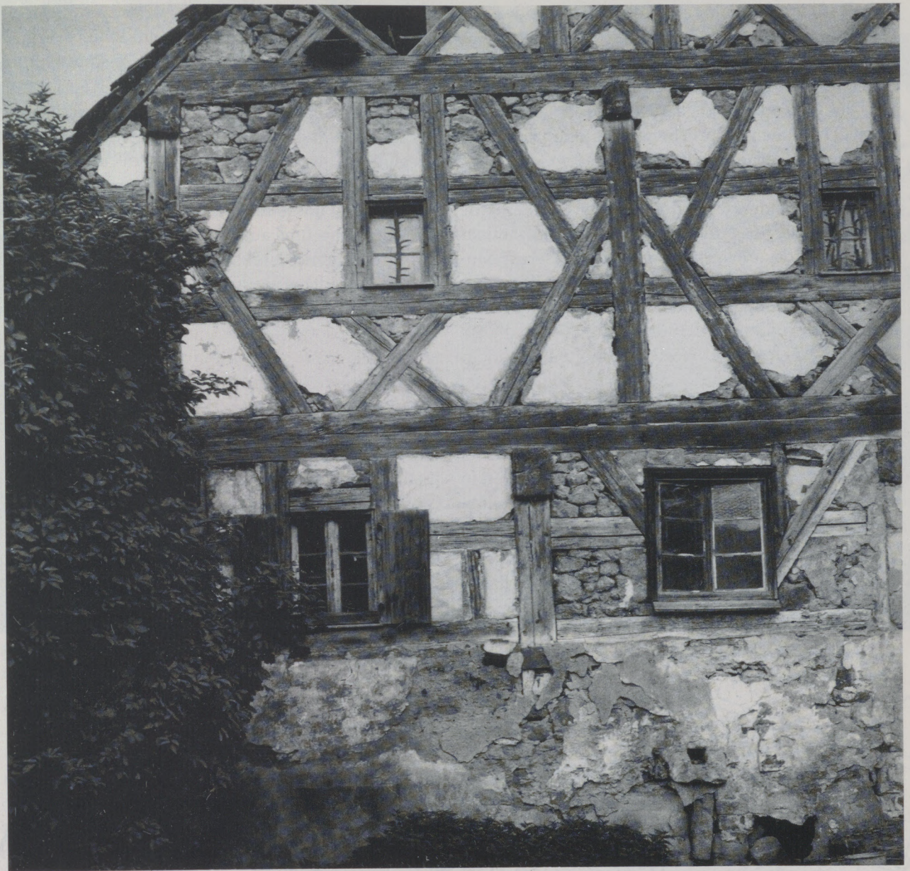
Giebelfront des Hauses aus Seubersdorf vor dem Abbau 1980
