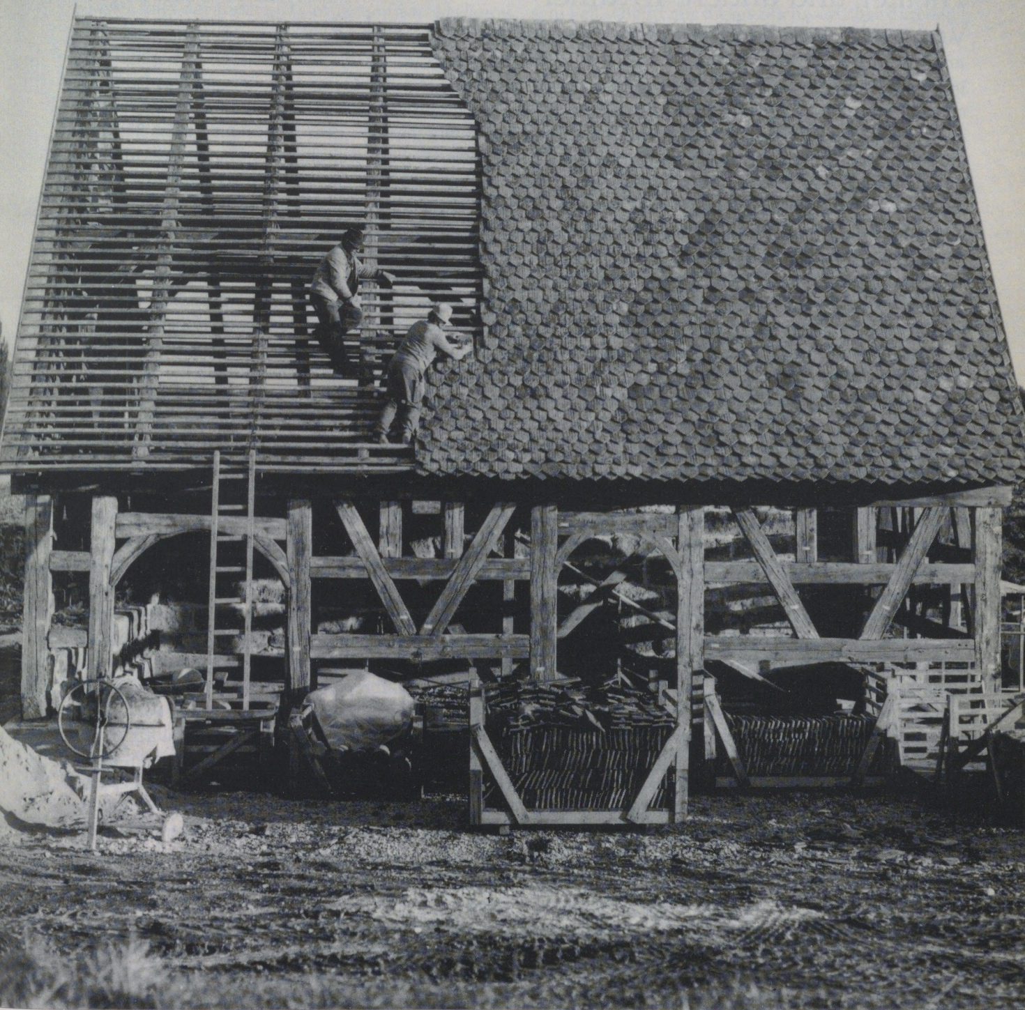
Nebenhaus aus Braunsbach beim Wiederaufbau 1980
