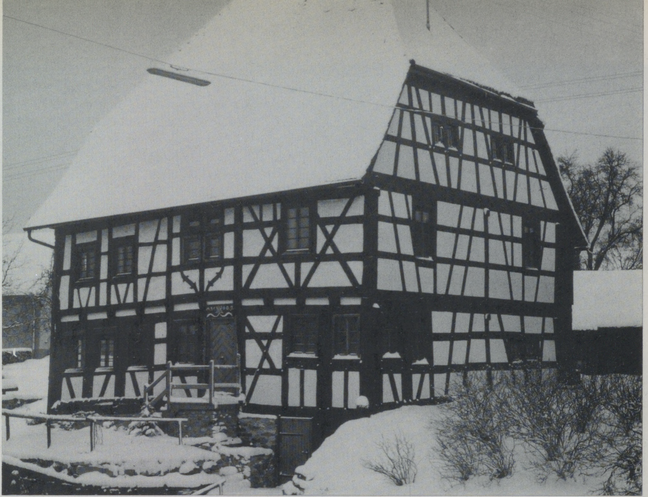
Das von Brigitte und Arthur L. Thomas vor dem Abbruch bewahrte und wiederhergestellte Haus Espachstraße 85 in Weilstetten (Stadt Balingen), auch Bühlburg genannt. Es handelt sich um den Rest einer ehemaligen Hofanlage. Charakteristisch sind die Übergangsformen des Fachwerks (vgl. die beiden Giebelseiten!) und das Krüppelwalmdach. Nach der sorgfältigen Erneuerung ist das Haus Wahrzeichen und herausforderndes Beispiel für die gesamte Ortschaft. (Foto links: G. Schneider, rechts: privat)
