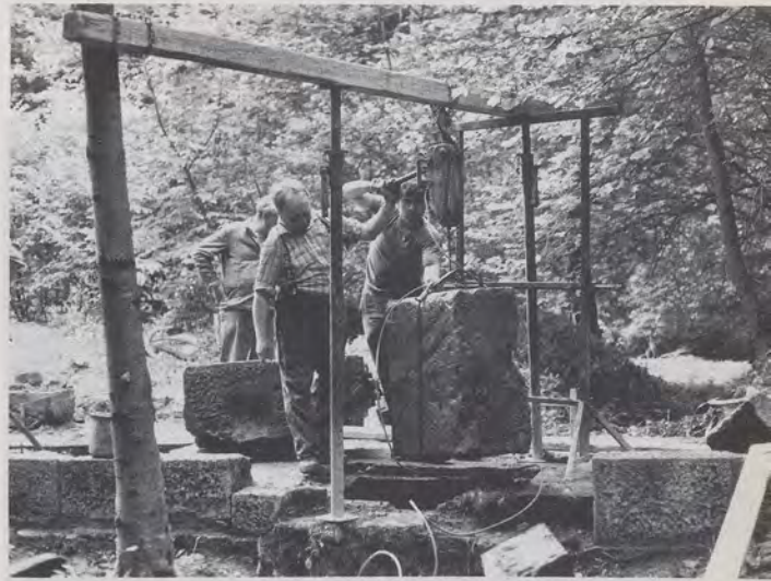
Etwa 100 m gronachabwärts errichtete Karl Bäuerlein 1897 ein Turbinenhaus, in dem eine 2,75 PS starke Voith-Turbine untergebracht war. Maurer bargen jetzt die Sockelsteine und fügten sie wieder zusammen. Die Turbine wird derzeit in der Voith-Lehrwerkstätte überholt.
