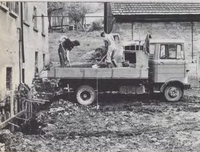
Renovierungsarbeiten an der Gröninger Hammerschmiede: Beim Anlegen eines Drainagegrabens um das Hauptgebäude kamen einsturzgefährdete Grundmauern zum Vorschein, die sofort mit Beton abgestützt werden mußten.
