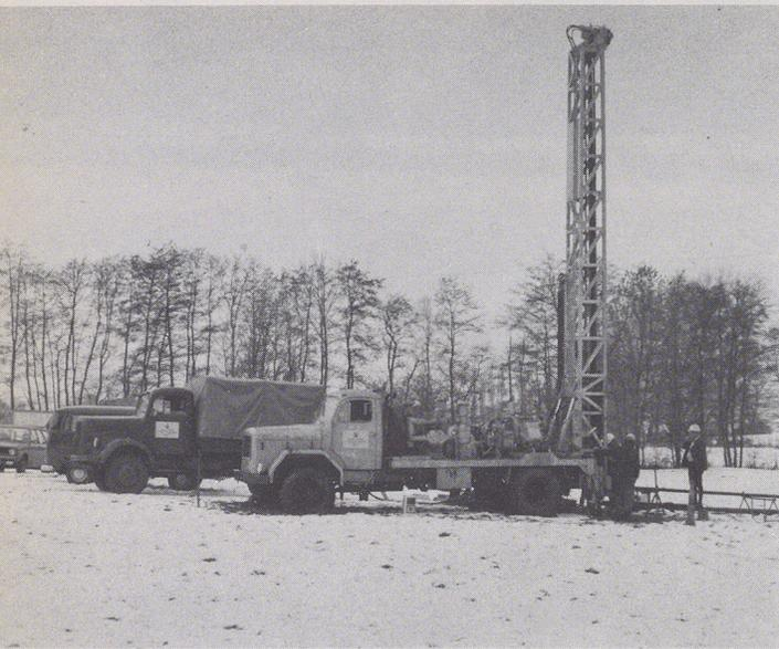
Flachbohrung zur Gewinnung von Bohrkernen für wissenschaftliche Untersuchungen.
