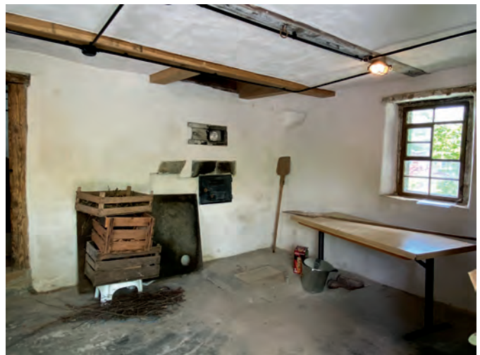
Die Backstube nach der Sanierung: an der Wand die Ofentür, darüber der frühere Rauchauslass und an der Decke der Abzug für den Rauch in den Schornstein
