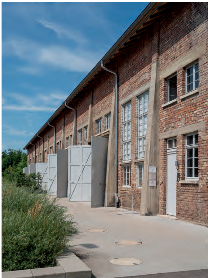
Die südliche Längsseite des großen Gebäudes: Durch die geöffneten Tore werden die neuen Einbauten belichtet.
