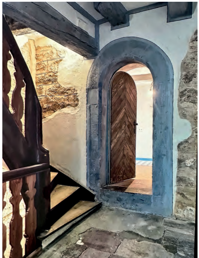
Blick in den Flur im ersten Obergeschoss des Steinhauses: Die Rundbogentür mit breitem Steingewände war im 13. Jahrhundert der Hauptzugang von einer Außentreppe.
