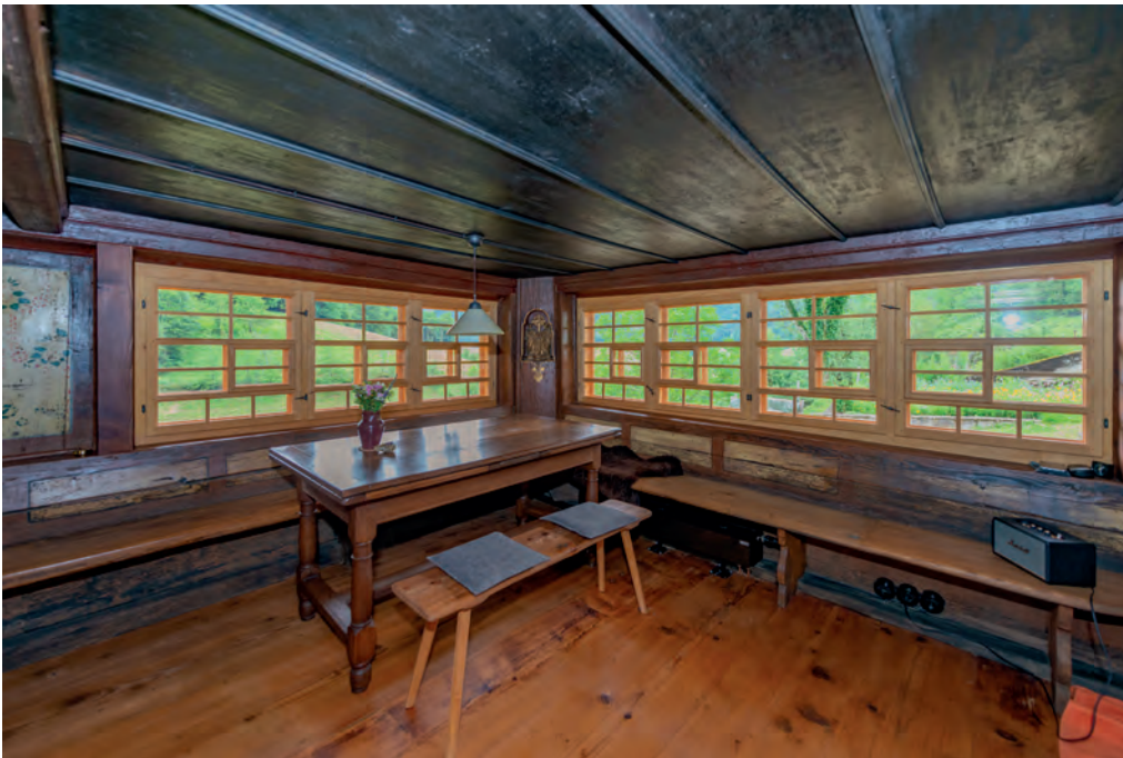
Die große Eckstube im unteren Geschoss: Das Fensterband rechts und links des Herrgottswinkels wurde in seiner Teilung wiederhergestellt.
