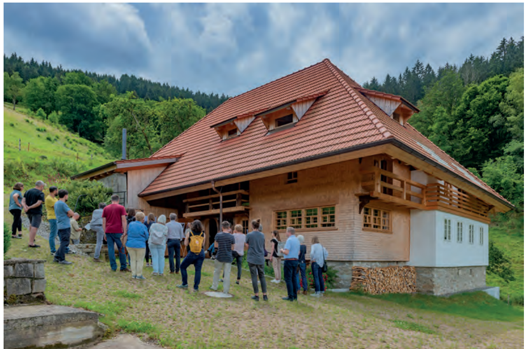
Der Farnrainhof in Elzach-Yach mit seinem weit überstehenden Dach über Eck gesehen: Der ursprüngliche Walm auf der Hauptschauseite zum Tal wurde rekonstruiert.
