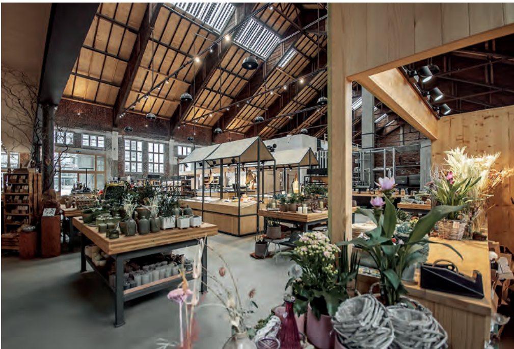
Blick in den Bereich der Markthalle: Im offenen Dachwerk sind die neu eingebauten Oberlichter mit den integrierten Solarmodulen zu erkennen.
