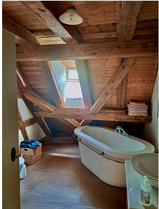
Badeinbau im Dachgeschoss: Die ursprüngliche Konstruktion des Dachstuhls wird bewusst offen gezeigt.
