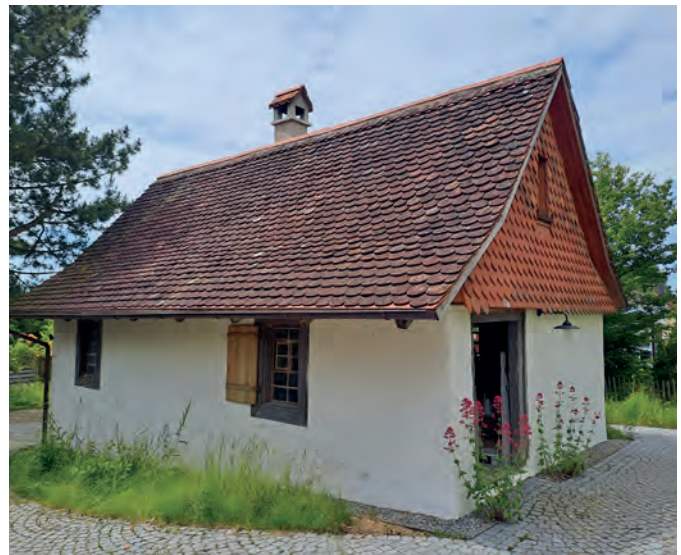
Das Backhaus des Bauensembles in Salem-Neufrach: Hier kann nach der vorbildlichen handwerklichen Reparatur wieder gebacken werden.
