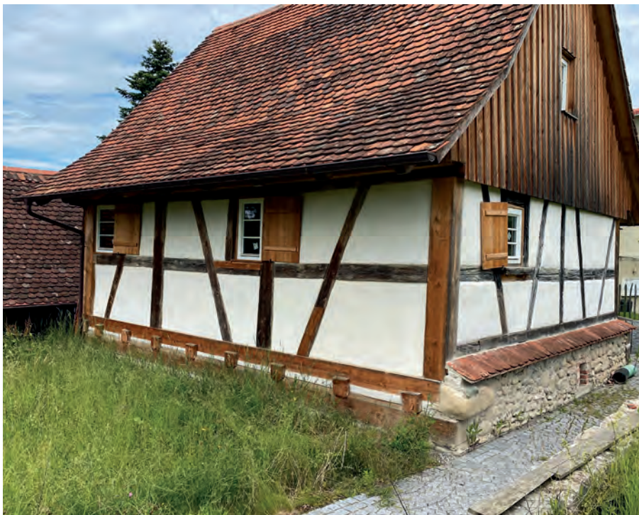
Das Fachwerkhaus mit verbreiterem Giebel: Trotz schwerer Schäden wurde viel von der Originalsubstanz erhalten.
