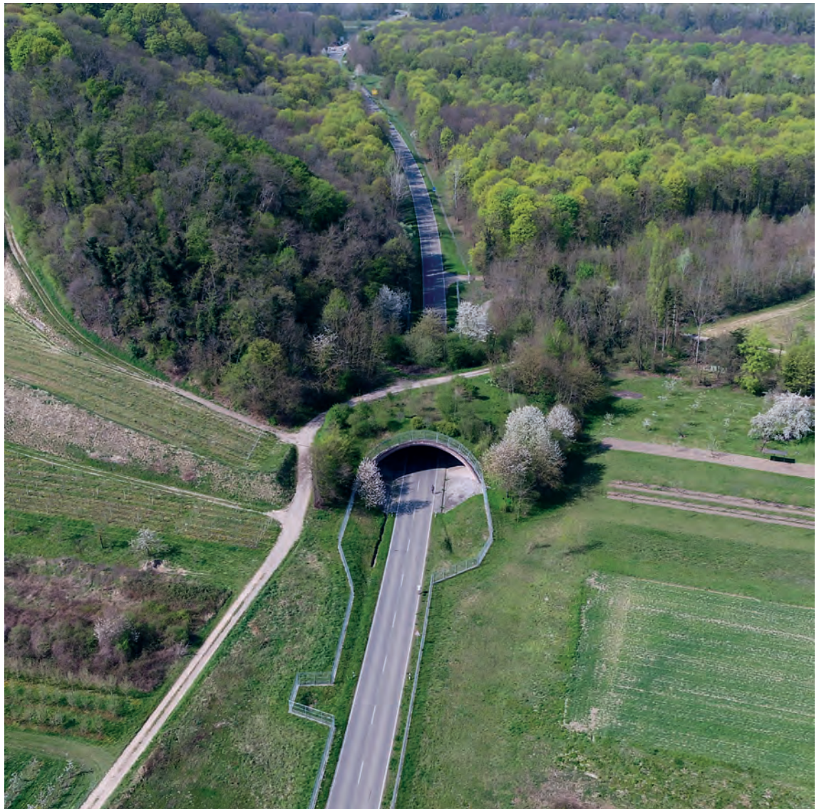
Grünbrücke Limberg bei Sasbach am Kaiserstuhl
