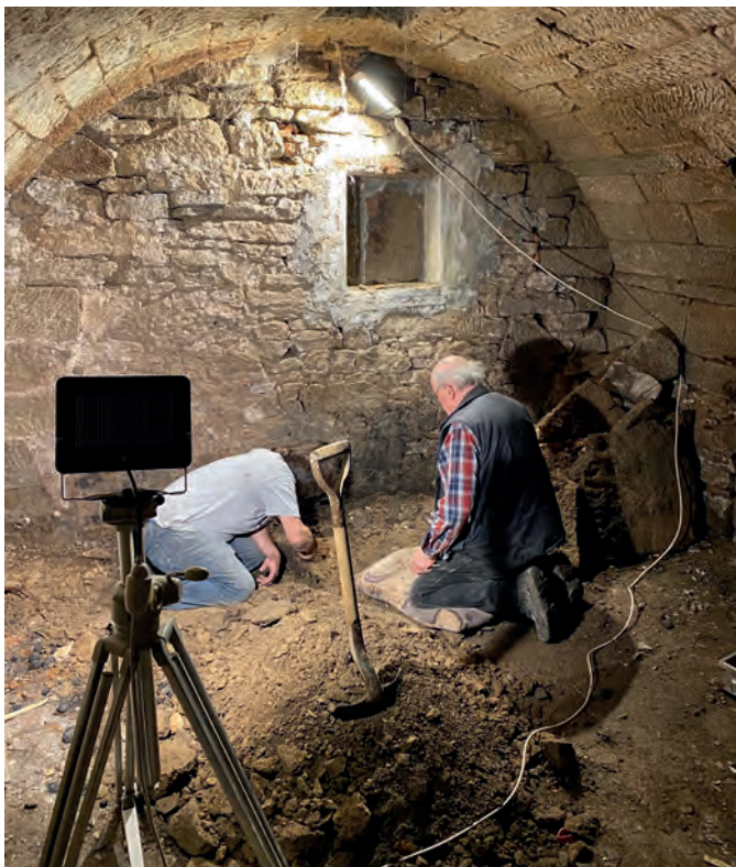
Die Töpfe ans Tageslicht zu befördern, verlangt behutsame Handarbeit.
