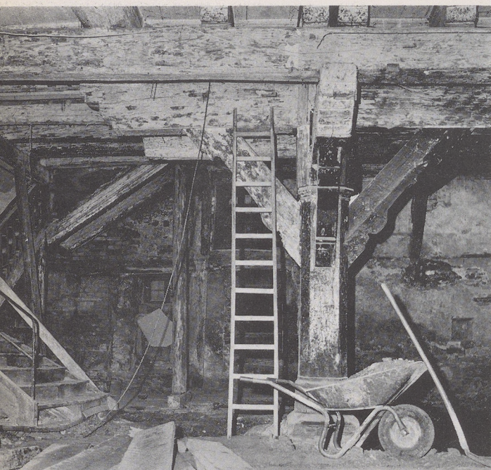
Die Eingangshalle mit der eichenen Mittelsäule von 1685 vor der Renovierung. (Foto: Städtisches Hochbauamt Schwäbisch Hall)
