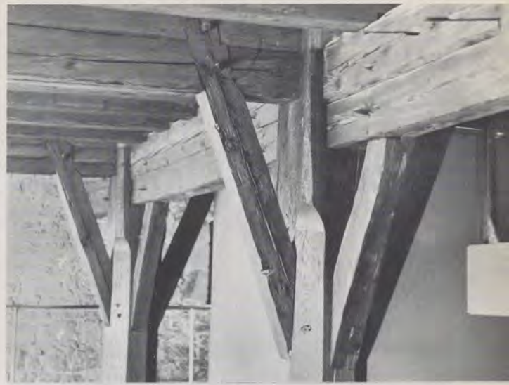
Innenpfosten mit Kopfbügen (Foto: E. Rohrberg).
