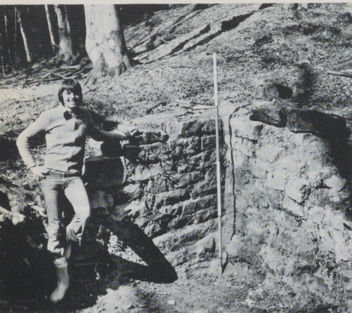
Abb.2 Die Nordwestecke der Kapelle, Trockenmauerwerk aus Rhätsandstein.
