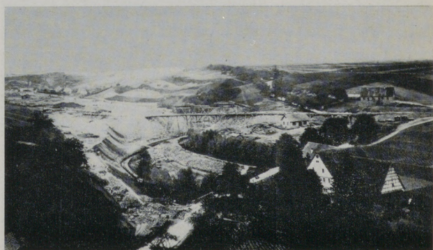
Abb. 4: Glemstal mit Clausenmühle im Vordergrund, links im Hintergrund Schweizermühle; Bau der Überführung für die Rutesheimer Straße und Bau einer Brücke über die Glems. Vor der Schweizermühle das Gelände, auf dem später der Leonberger Bahnhof gebaut werden sollte. Foto 1867 oder 1868 (Fotosammlung Schüz Nr. 4 / Sammlung Schmidbauer Nr. 7).
