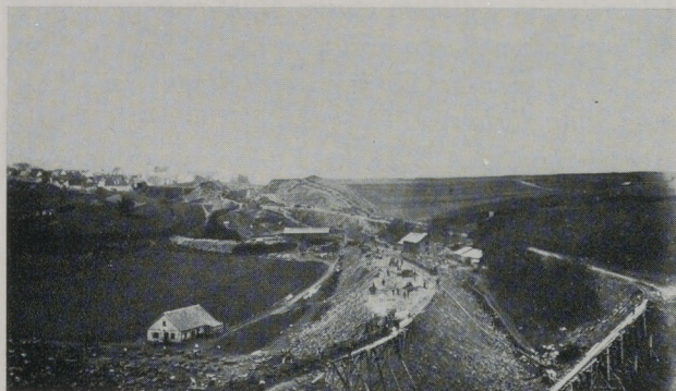
Abb. 2: Im Hintergrund Leonberg mit Kirche und Schloß; rechts neben dem Schloß Bau am 23 m tiefen Einschnitt, im Vordergrund Dammaufschüttungen mit mehreren Rollbahnen. Foto 1867 (Sammlung Schmidbauer Nr. 4).
