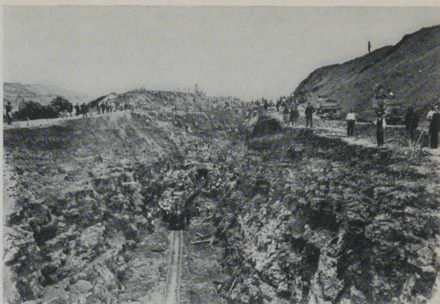
Abb. 3: Im Vordergrund Sohle des Einschnitts bei Leonberg; im Mittel- und Hintergrund Ausschachtungsarbeiten; über 260 Menschen befinden sich auf diesem Bild. Foto 1867 oder 1868 (Sammlung Schmidbauer Nr. 3).
