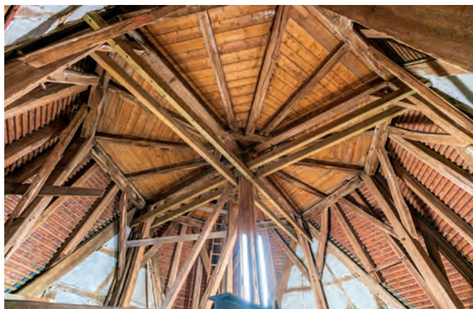
Der Dachstuhl des Kirchturms
