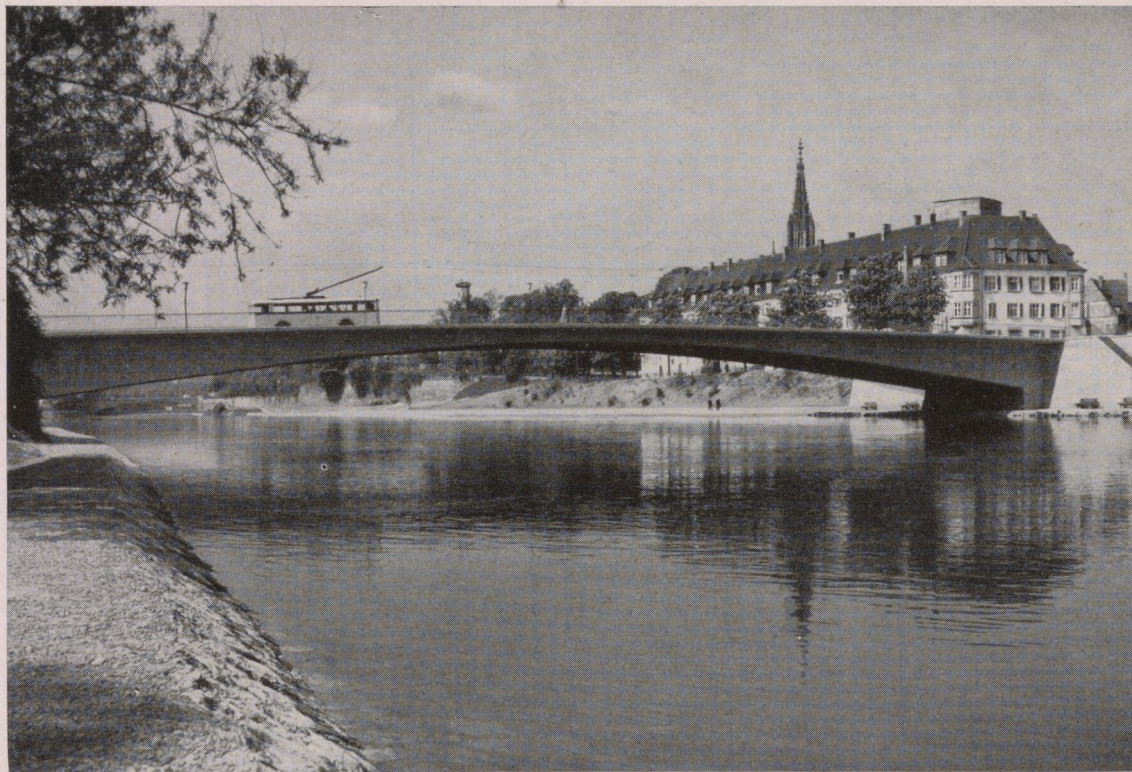
Die neue Gänstorbrücke. Im Hintergrund die neue Herdbrücke
