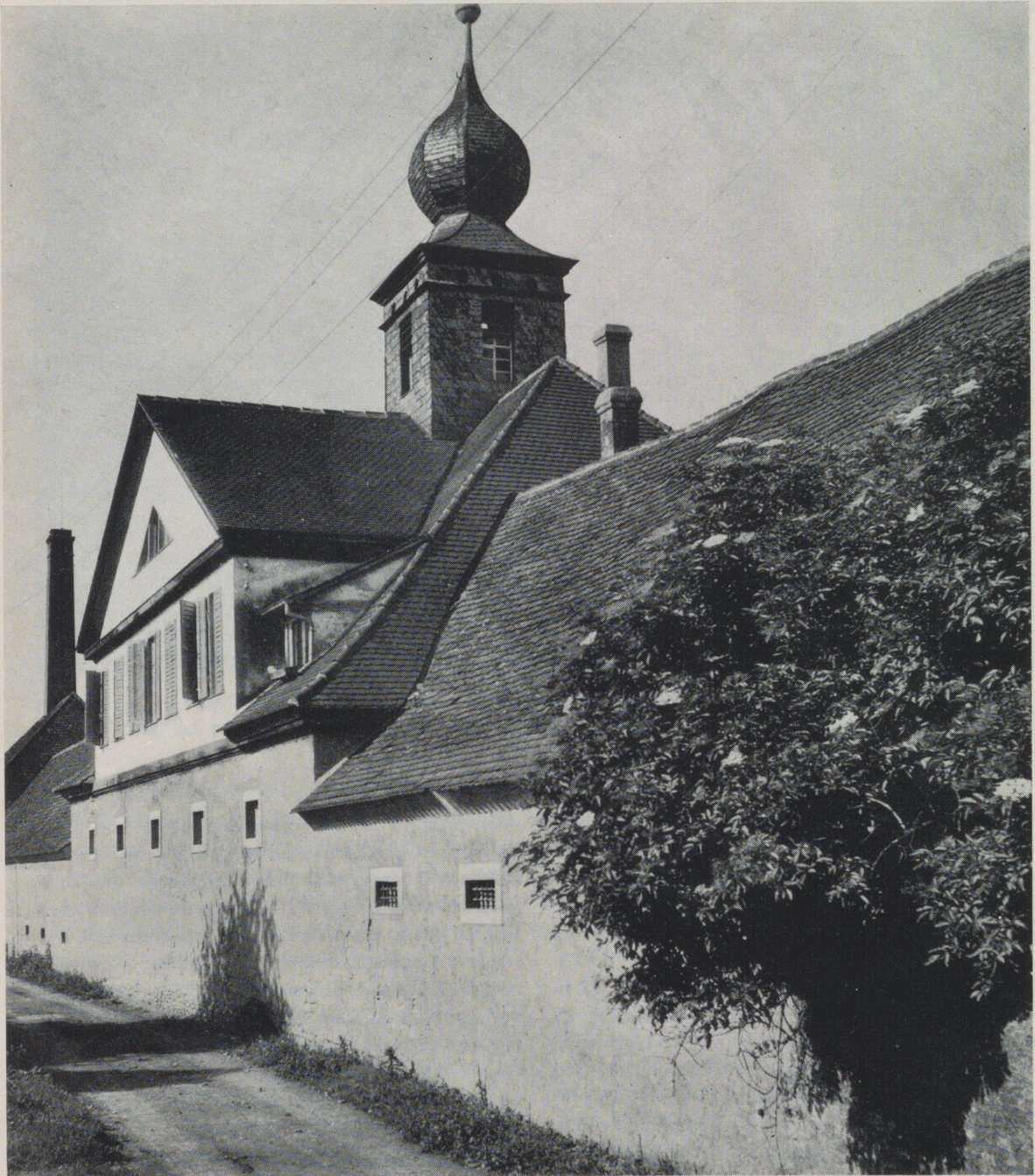
Mittelbau der ehemaligen Saline Clemenshall bei Offenau
