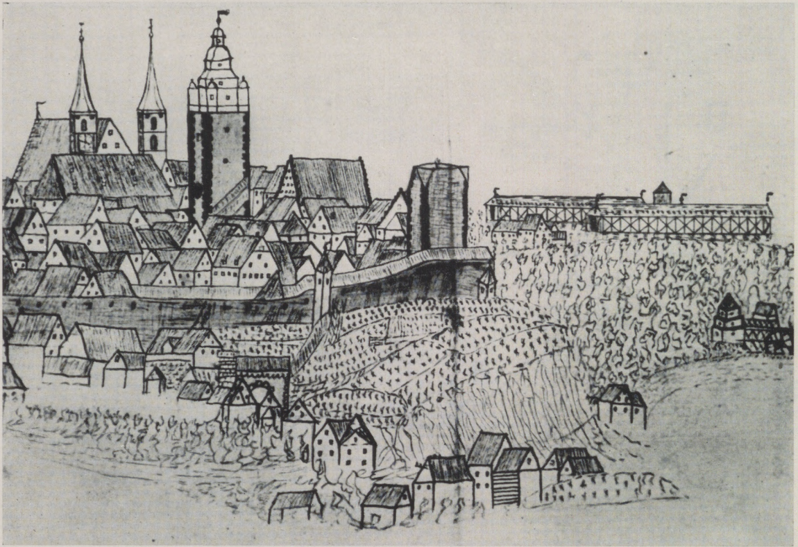
Städtische Saline Wimpfen. Vor 1796. Auf der Anhöhe rechts der Stadt zwei Gradierwerke, fälschlich parallel gestellt. Vorn das kleine Siedehaus. Unten am Neckar beim Stolleneingang der turmförmige Aufbau des oberen Solebrunnens sowie die Triebräder der Wasserkunst.
