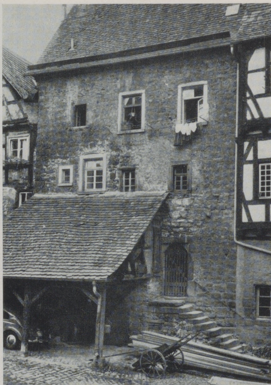
Wimpfen, Bürgerhospital. Der Bauteil von etwa 1230 mit dem davorstehenden Schuppen vor der Freilegung 1962. Aufnahme Arens
