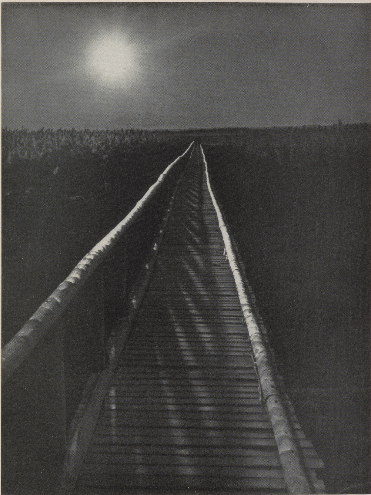
4. Abendstimmung auf dem Federseesteg. 1911 wurde der Seesteg von Oberförster W. Staudacher angelegt (700 m lang), 1949 von der Stadt Buchau erneuert und auf 1100 m verlängert, da die Verlandung des Sees inzwischen weit fortgeschritten war. Die Pfähle mußten bis zu 9 m tief in Moor- und Seegrund getrieben werden.
