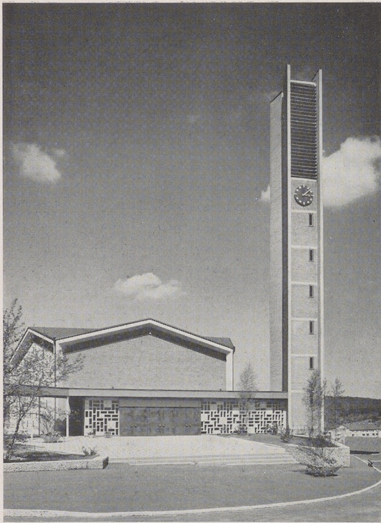
Evang. Christuskirche in Sindelfingen Architekten H. Rall und H. Röper, Stuttgart. Fertiggestellt 1959. Aufnahme G. Planck
