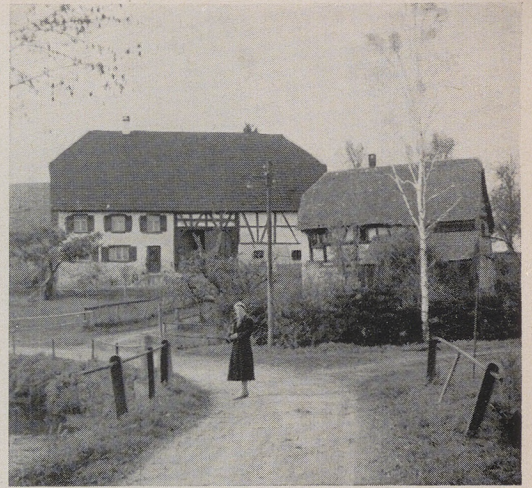
12 a. Neubau des Hauses Schmid
