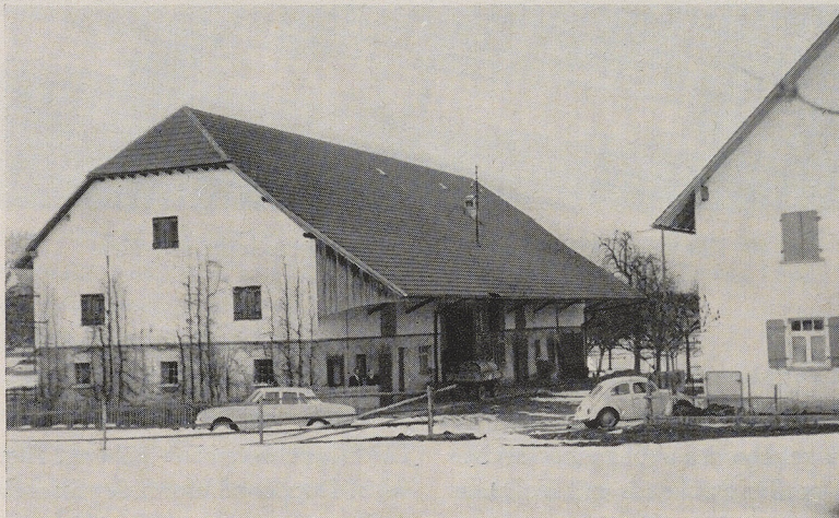
11 a. Unter-Atzenberg. Neubau eines Stadels an der Stelle des abgebrannten Hauses
