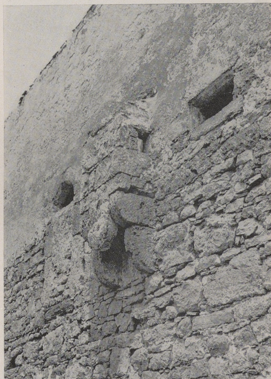
Die vermauerte Eingangstüre mit Rundbogen an der Südwestseite. Daneben der aus sauberen Werkstücken zusammengefügte Erker und eines der typischen Fenster
