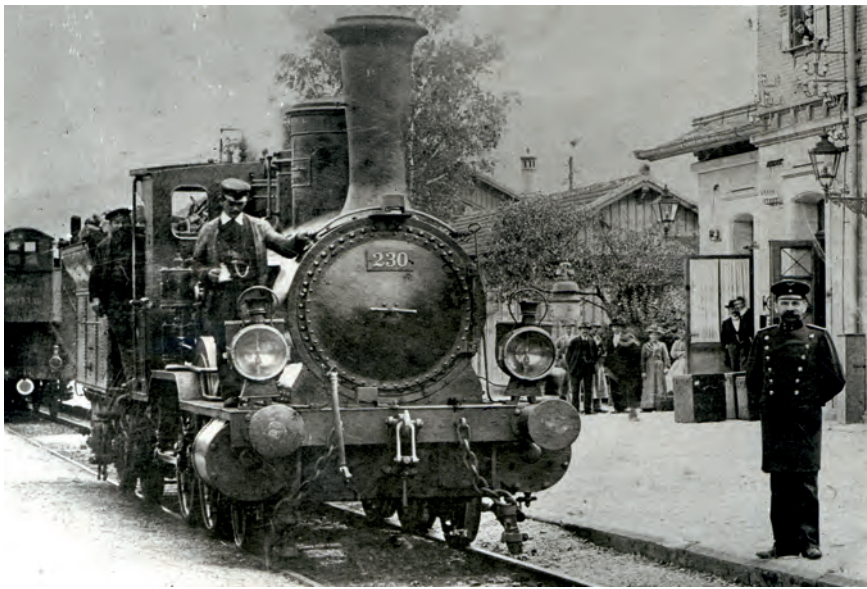
Nachdem die Remsbahn schon in den 1860er-Jahren gebaut worden war, folgte die Murrbahn ein Jahrzehnt später: 1876 war Backnang erreicht, 1878 Murrhardt – hier im Bild. Dann wurde nach Gaildorf weitergebaut. 1911 folgte die Wieslaufbahn nach Welzheim.
