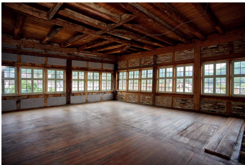
Das Fensterband der großen Stube von innen
